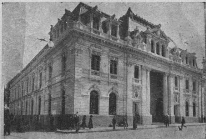
Oficinas Centrales del Servicio de Correos
